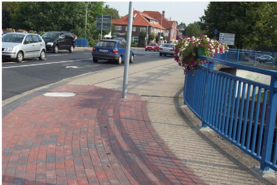
Ampelmast vor Kanalbrücke Richtung Osten
