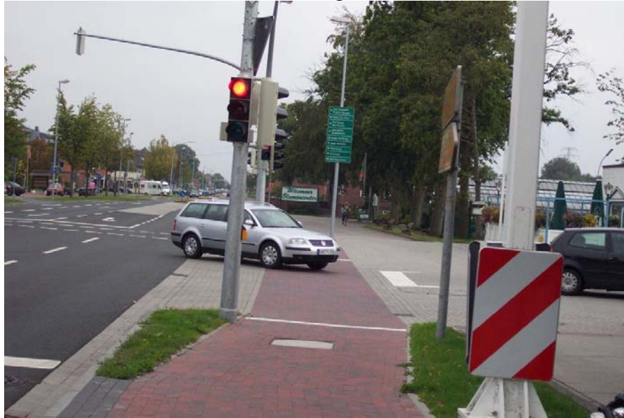
ARAL-Tankstelle: Signallicht am hinteren Mast für Fahrradfahrer nicht zu erkennen
